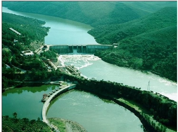
Central Hidráulica de Torrejón, en el río Tajo
