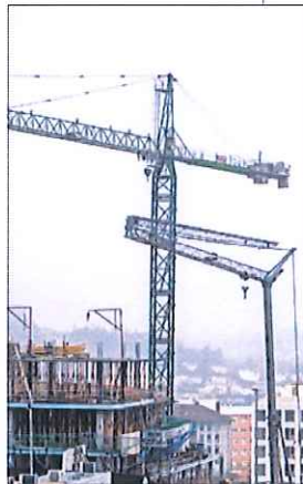
Obras en Santiago de Compostela. / OSCAR CORRAL
