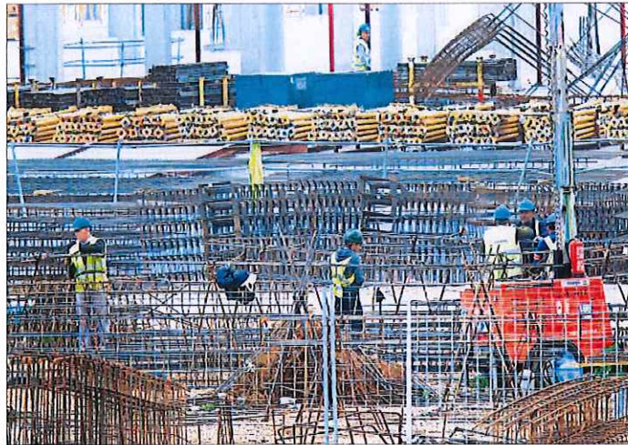
Un grupo de albañiles, en una obra en Sevilla. / PACO PUENTES
