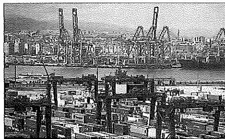
Una terminal del puerto de Algeciras (Cádiz). / MARCOS MORENO
