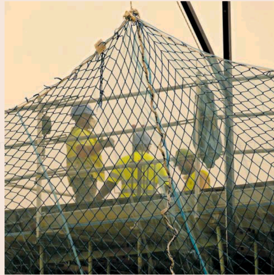
Varios trabajadores en una obra en Sevilla. PACO PUENTES
