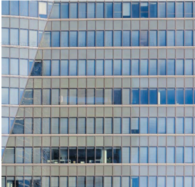
Edificio de oficinas en el norte de Madrid. EDUARDO PARRA (EP)
