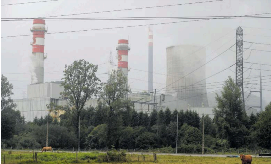
Central de ciclo combinado de Soto de Ribera (Asturias). ELOY ALONSO (EFE)
